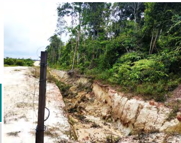
Parit yang dibina untuk menghalang laluan gajah di J-PL1
