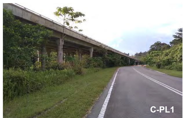
Sebahagian jalan masuk sisi di eco-viaduct Sg. Yu yang berjaya ditutup.
