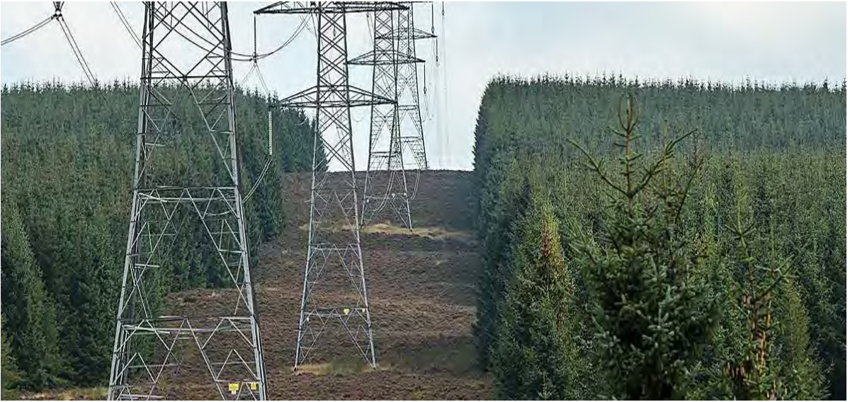
Gambaran kaedah pengawalan vegetasi di koridor utiliti rentis sedia ada / tradisional.
