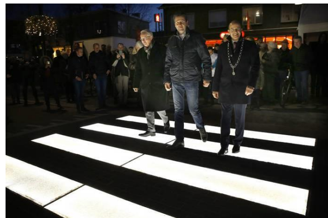
Contoh smart zebra crossing yang diintegrasikan dengan lampu LED untuk kegunaan pada waktu malam
