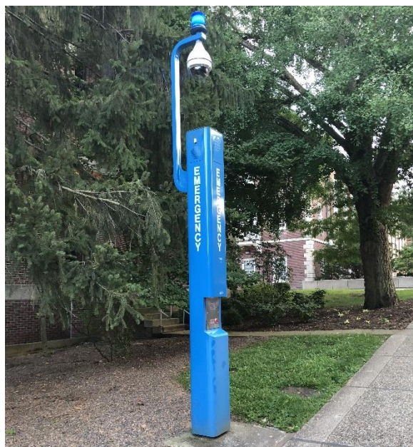
Contoh Penyediaan panic button ( emergency pole ) yang dilengkapi dengan CCTV di laluan pejalan kaki di USA.
