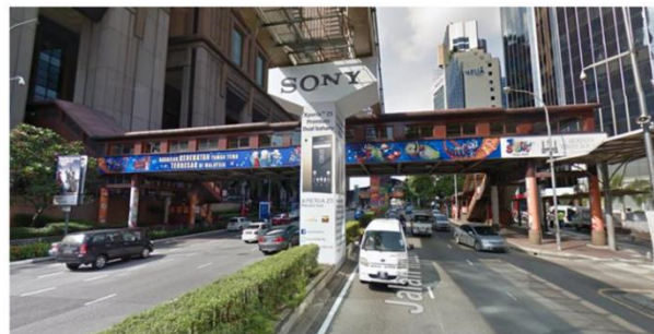
Contoh reka bentuk jejantas di Time Square yang menghubungkan dua bangunan perniagaan.
