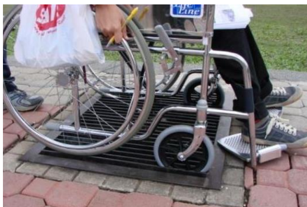
Contoh penutup longkang yang tidak mesra pengguna kerusi roda.
