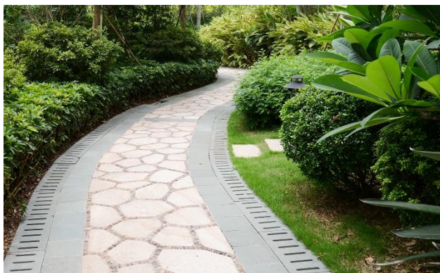
Contoh permukaan laluan pejalan kaki yang rata dan kedudukan longkang yang tidak menghalang pengguna kerusi roda.
