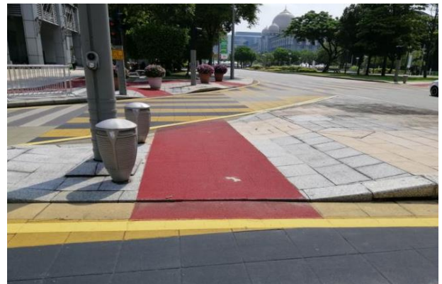
Contoh pulau lindungan pejalan kaki di Putrajaya yang luas dan memiliki kelebaran yang selesa
