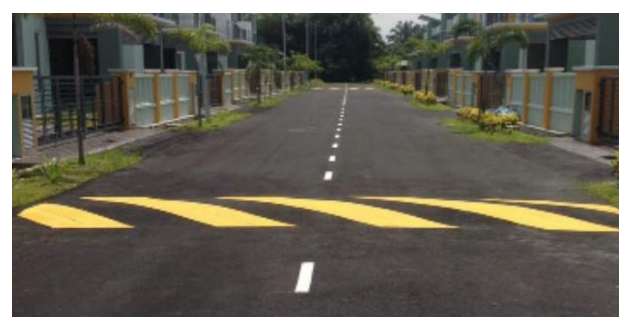
Contoh komponen fasiliti redaan trafik; bonggol jalan yang diletakkan di Kawasan perumahan.
