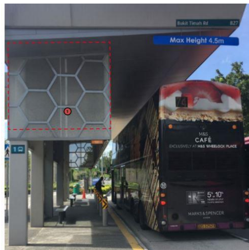
Perhentian bas berbumbung tinggi di Singapura yang dilengkapi dengan drop panel .
