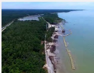
Kejadian Hakisan Pantai di Pantai Kelanang
