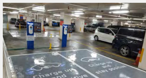
Kemudahan pengecas kenderaan elektrik (ChargEV) di Tempat Letak Kenderaan Suria KLCC
