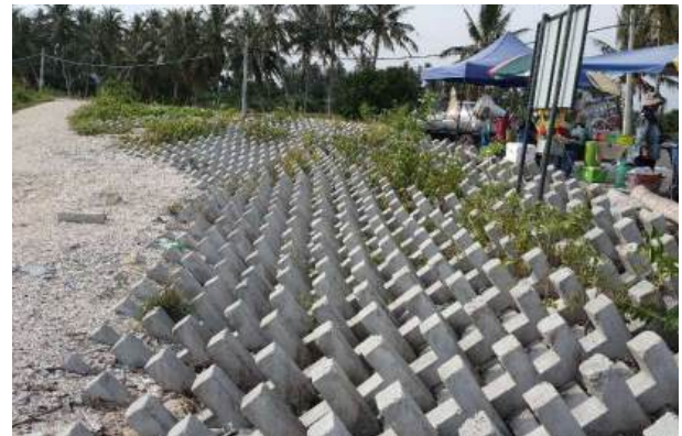
Kaedah pertahanan pantai menggunakan batu lapis lindung di Tg Piandang, Perak.
