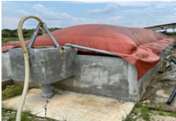
Tangki fermentasi biogas untuk jana elektrik
