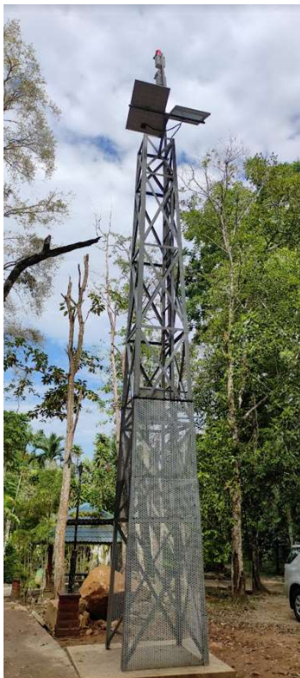
Sistem Amaran Awal Bencana Geologi Aliran Puing yang telah dipasang di Jerai Geopark, Titi Hayun, Kedah
