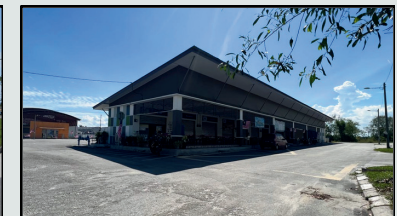
2. Gerai Makan (10 Unit)
