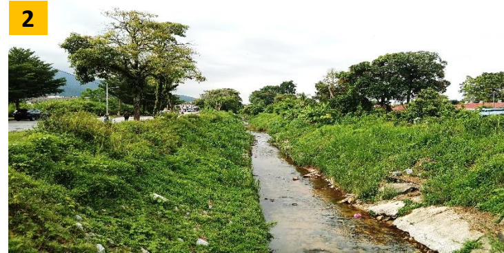
2 Keadaan tebing sungai yang kurang terjaga dan dipenuhi semak
