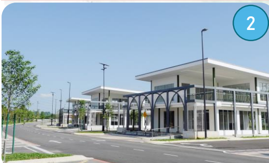
Keadaan semasa bangunan Tebing Avenue
