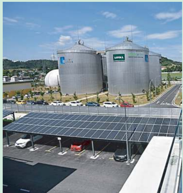
Loji Kumbahan Pantai 2 STP yang terbesar di Malaysia terletak di Pantai Dalam, Kuala Lumpur
