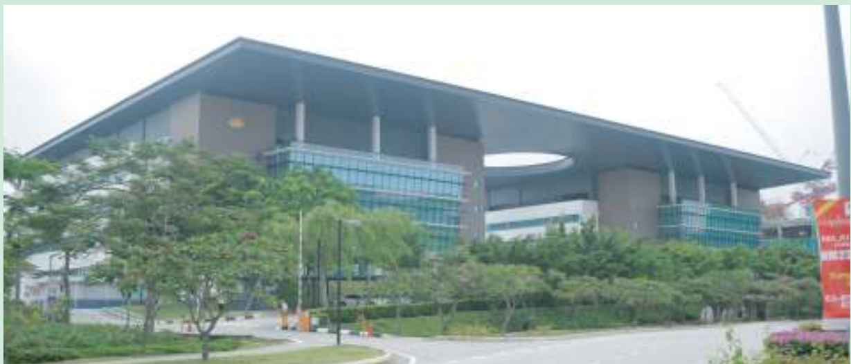
Bangunan Wisma Shell yang mendapat penarafan emas Kepimpinan dalam Rekaan Tenaga dan Alam Sekitar (LEED) tersergam Indah di Cyberjaya, menjadi contoh pembangunan hijau di Malaysia
