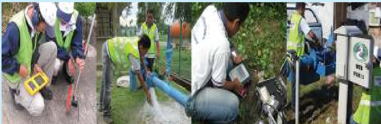
Pemeriksaan dan penggantian paip-paip lama sedang dijalankan
