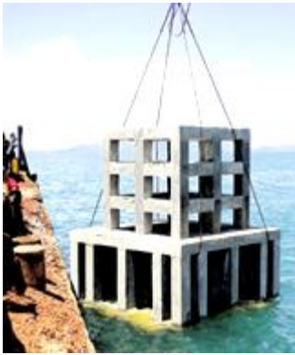
Tukun tiruan konkrit dasar lembut dibina lebih tinggi untuk mengelakkannya daripada tenggelam.
